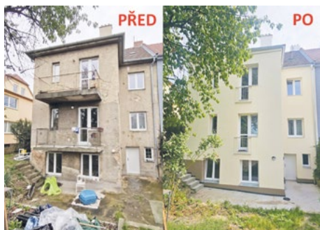
Dům Lužná 21 prošel revitalizací zahrnující sanace, opravy i zateplení a výměnu klempířských prvků
